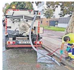
Operario limpiando imbornales.
